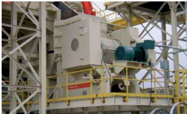
Montage einer neuen Vorbrechanlage mit C145.
