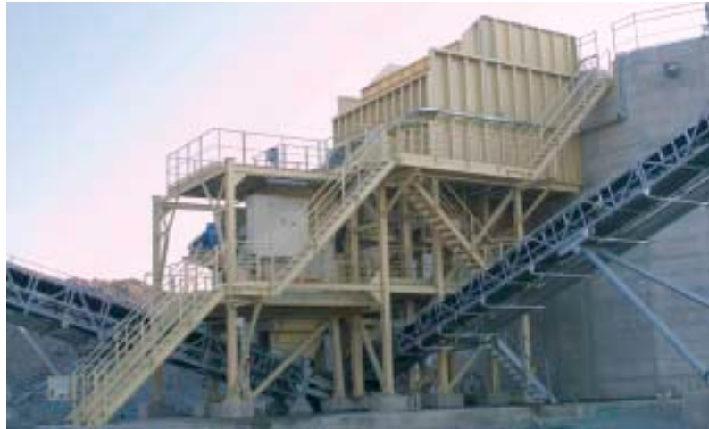
Montage einer neuen Vorbrechanlage mit C125.
