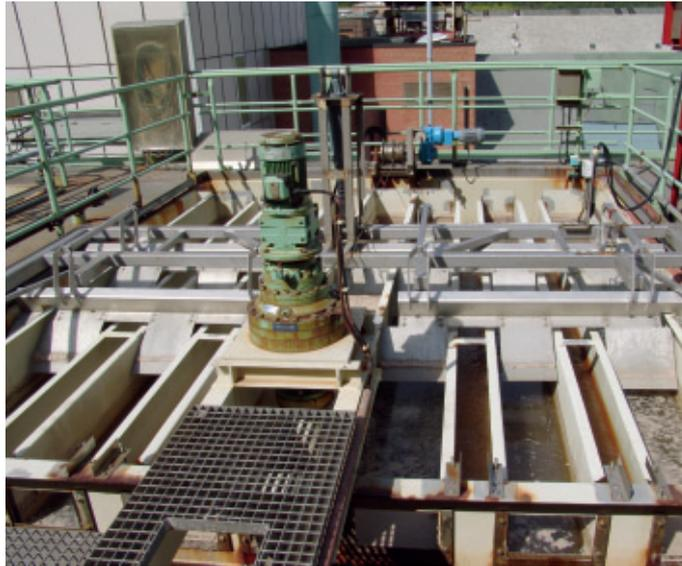
*Bild 8: Schaumdekanter auf den Eindickern im Werk Hattorf
