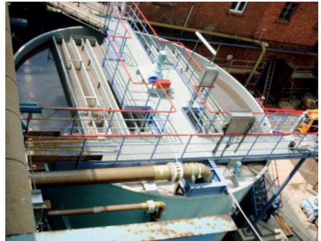
Bild 7: Der erste der drei neuen Rundeindicker im Probelauf
