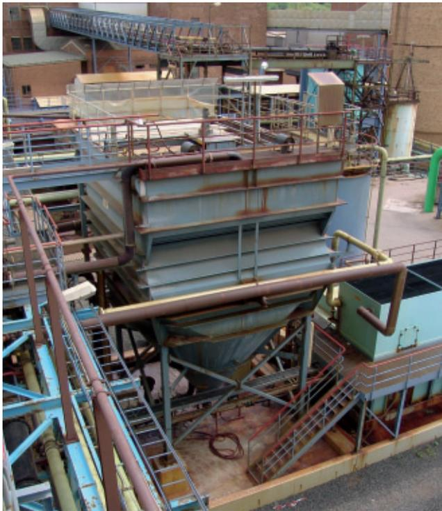
*Bild 3: 500-m<sup>2</sup>-Setl-Eindicker in rechteckiger Bauform
